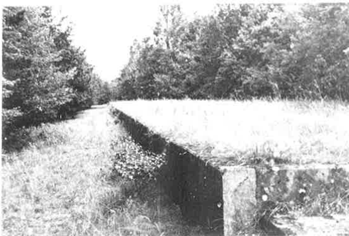
Viel ist von der Bahnlinie nicht übriggeblieben. Nur die Bahnsteigkante (Foto), einige Schwellen, die Reste der Straßenüberführung und die Treppe von der Straße zum Bahnsteig erinnern an die Zeiten, als hier noch Züge hielten.
