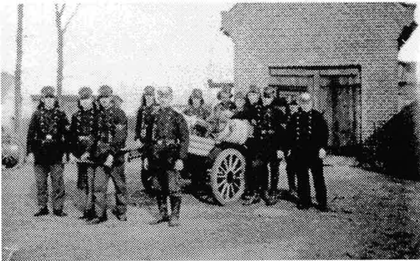
Die wohl erste Aufnahme von der Leegebrucher Feuerwehrtruppe. Sie zeigt den hartgummibereiften Anhängewagen. Das Gebäude im Hintergrund ist das Spritzenhaus, der älteste Teil des heutigen Feuerwehrdepots, direkt unter dem Schlauchturm, der erst in den 30er Jahren entstand. Vorn in der Mitte Gustav Krumpa, ganz rechts Federwisch.
